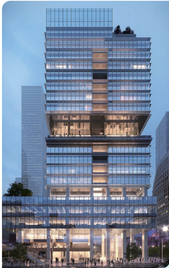
深圳市的中国海外大厦项目
